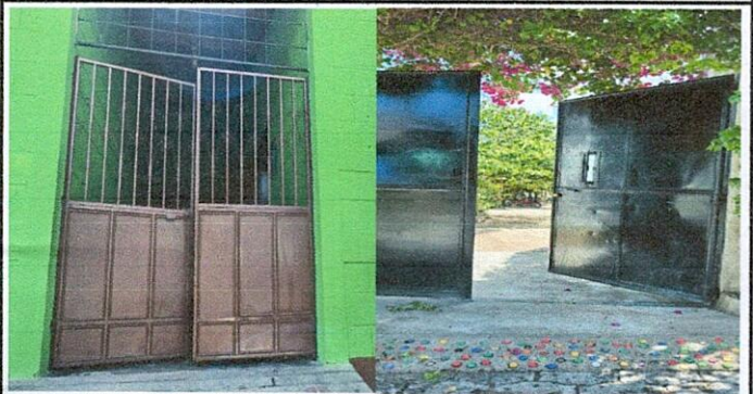
Foto 5: MEJORAMIENTO A PORTONES Y ENTRADA DE ABAJO
